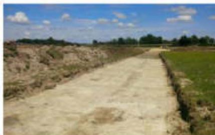
Les chemins et virages sont renforcés et/ou créés, afin de supporter le passage des convois exceptionnels.
