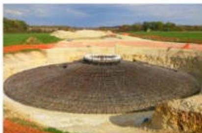
Des fouilles de près de 30 m de diamètre et de 3 m de profondeur sont creusées pour y accueillir les fondations des éoliennes.
