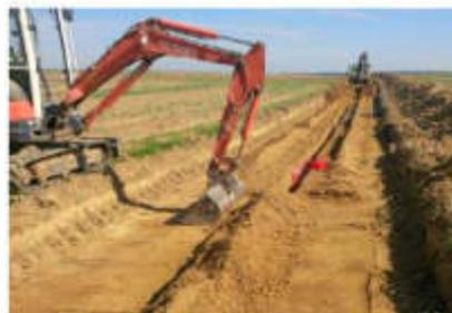
Le câblage est réalisé par trancheuse et pelleteuse. Avant le passage du câble, la terre végétale est décapée, stockée, puis remise en place pour garantir la qualité des cultures.
