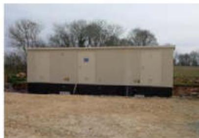
Le poste de livraison installé par ENERTRAG assure principalement les fonctions de comptage de la production, de protection électrique de l'ensemble du parc et de communication avec le centre de gestion.
