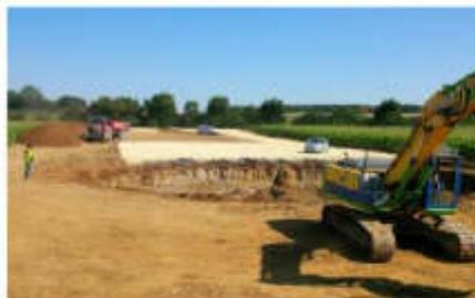
Des plateformes de 1 000 m<sup>2</sup> en moyenne sont prévues au pied de chaque machine pour accueillir les grues de levage des éoliennes.
