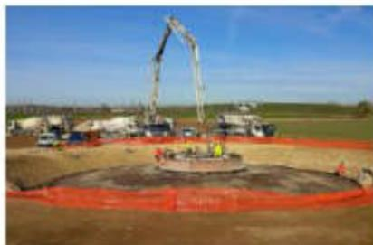
Puis, le béton est coulé dans le fond de la fouille. La fondation est inspectée une semaine après le coulage pour s'assurer de sa conformité.
