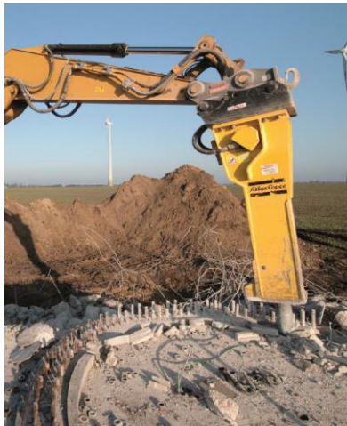
Destruction au BRH (séparation de l'acier et du béton)
